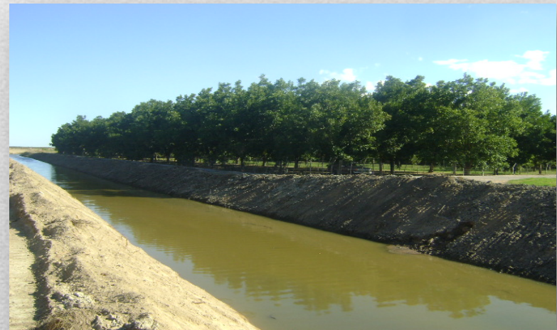
ADECUACION DE LA SECCION DREN INTERCEPTOR
