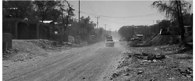
Calle sin pavimento en Nogales, Sonora
