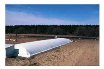
Figure C-9. 135 kW Dairy Manure Digester.<sup>5</sup>
