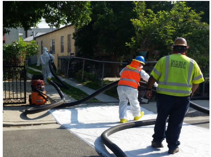
Figura 2: Los equipos de limpieza eliminando las cenizas del exterior de una propiedad residencial en la calle E. 52nd St.
