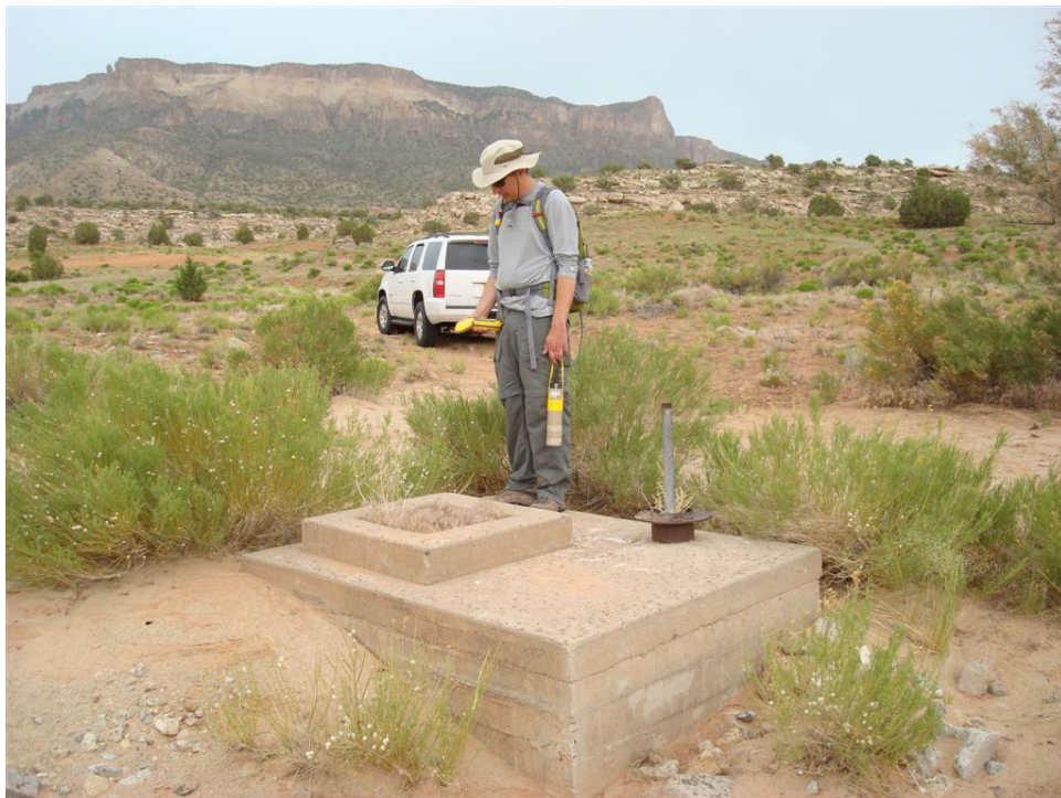
Photo 4. Saytah site, concrete pad
