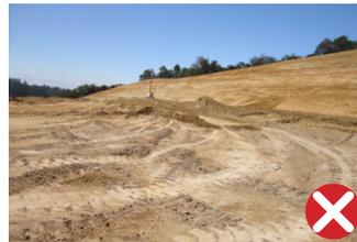
Gran área de perturbación en un sitio de construcción inactivo que no contiene las prácticas de estabilización puede permitir que la erosión ocurra
