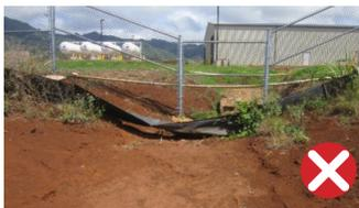
Valla Barrera colapsada instalada en áreas de flujo concentrado
