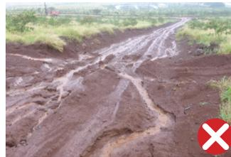
Carretera de construcción perturbada erosionando durante la lluvia
