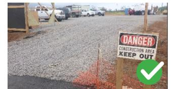
Buen mantenimiento de la plataforma de grava en la entrada de construcción
