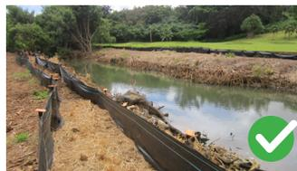
Instalación y mantenimiento adecuados de la valla barrera a lo largo de la vía fluvial
