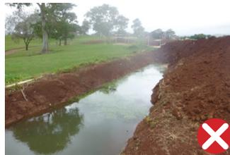
Pila de tierra descubierta y desestabilizada ubicada junto a la vía fluvial
