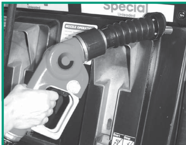
Inuutos ng Clean Air Act ang pagkakabit ng mga vapor recovery nozzle sa mga gasolinahan sa ilang lugar. Ang mga gas pump nozzle na ito ay nakakabawas sa pagbuga ng singaw ng gasolina sa hangin kapag naglalagay ng gasolina ang mga tao sa kanilang sasakyan.
