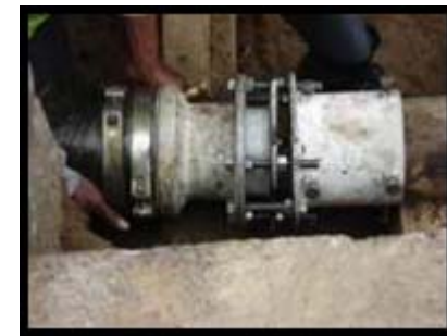
Прикрепление к основной трубе
