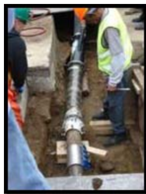
Вкладыш выворачивается внутри основной трубы
