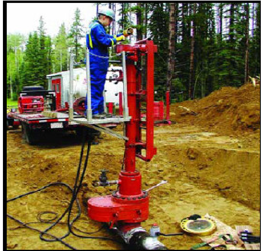
Técnico certificado de Williamson Industries realizando una conexión hot-tap con una Máquina de Conexiones durante la aplicación de un tapón de 12”
