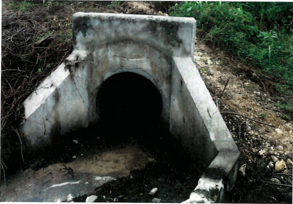
Canales de drenaje
