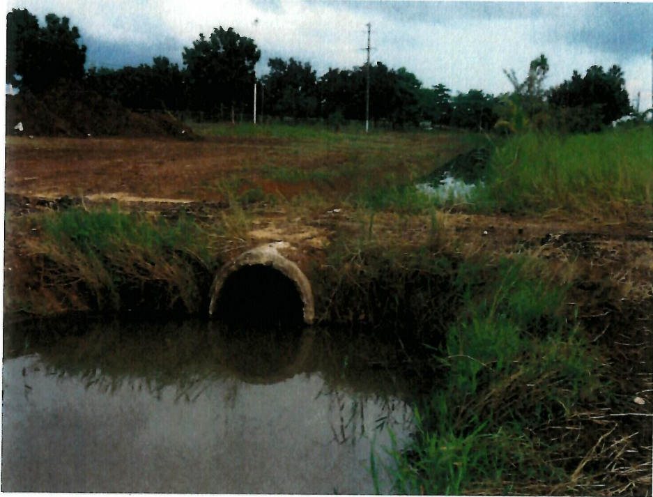
Canales anexo Complejo Villa Georgetti
