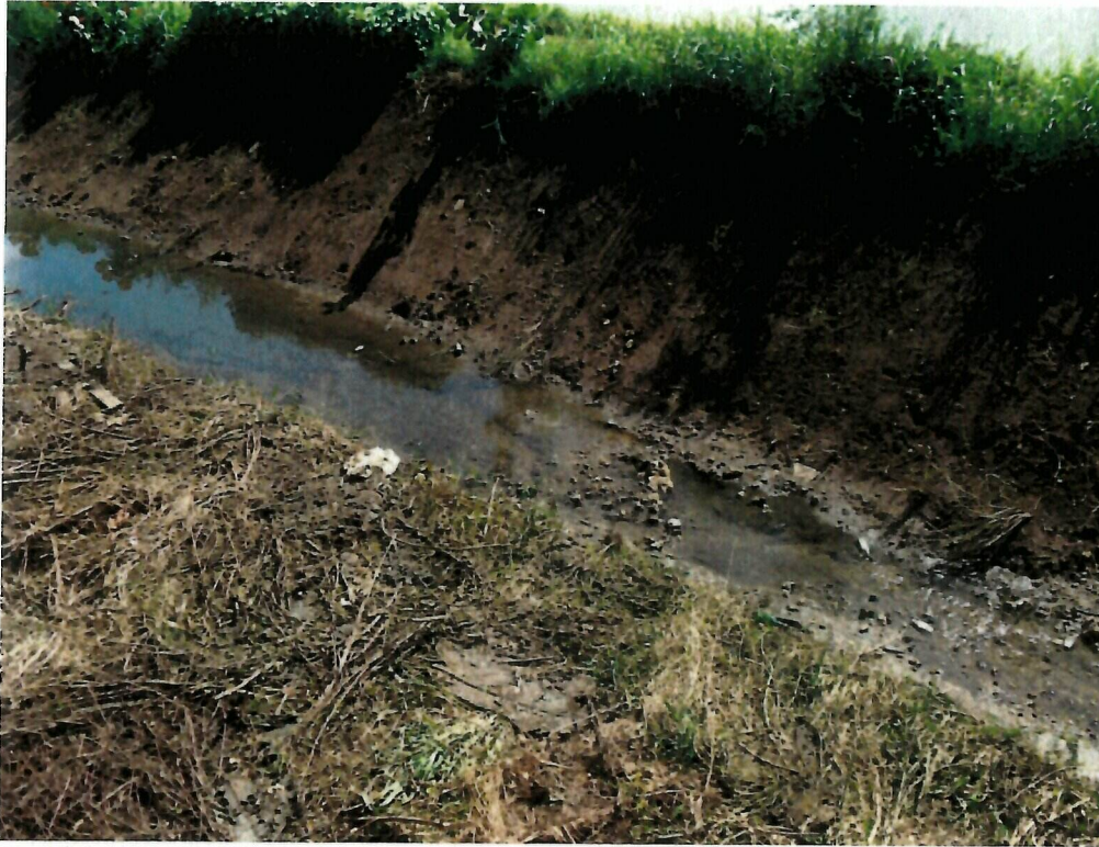
Canales anexos al dique
