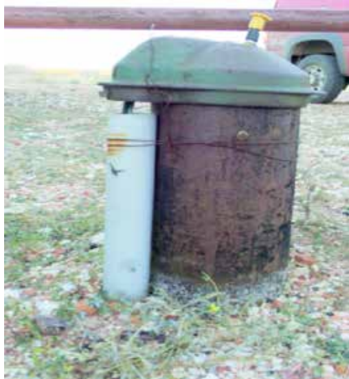
Conduit not sealed
