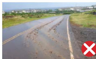
Los vehículos rastrean sedimentos a la carretera
