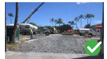
Buen mantenimiento de la plataforma de grava en la entrada de construcción con un mínimo de sedimentos fuera del sitio
