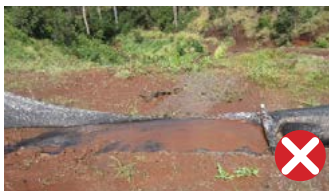
Valla Barrera sin mantenimiento
