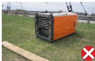
Baño portátil no asegurado y volcado por materiales de construcción
