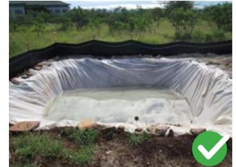
Pozo de lavados de concreto forrado con láminas de plástico
