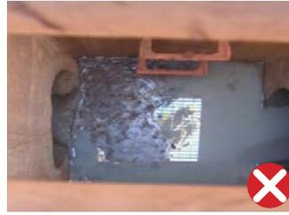
Concreto lavado en un Embalse de Retención de drenaje pluvial
