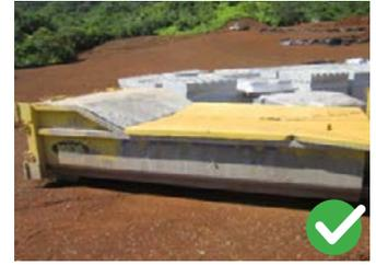
Estructura de lavados de concreto con cobertura
