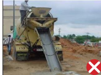
El empleado manguerea el barril y canal de concreto sobre la superficie de la tierra
