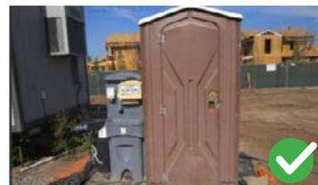
Baño portátil asegurado al suelo para evitar que se vuelque y posicionado en una lona para contener cualquier fuga que pueda ocurrir
