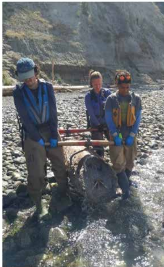
Se retira un pilote de creosota de Lopez Island, WA.
