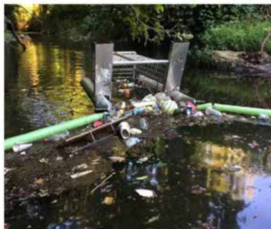
Dispositivo de captura de basura en Proctor Creek, Atlanta.
