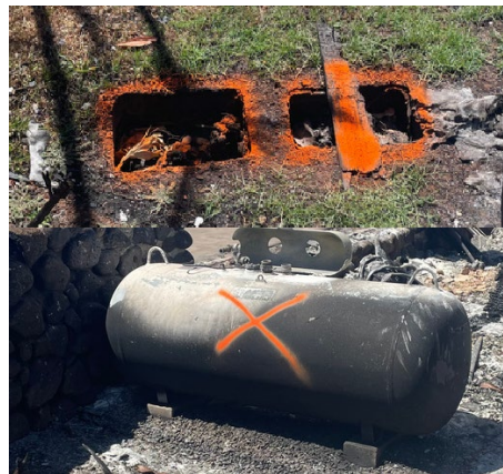
Orange na pintura = Lokasyon ng septic system, sirang transformer, o delikadong item na iniwan sa site.
