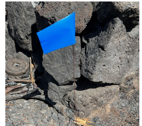
Asul, pula, orange, o dilaw na survey stake, flagging, o streamer = Potensyal na lugar na sensitibo sa kultura o pag-iingat sa paggamit ng item. Asul na flagging ang pinakanagamit.
