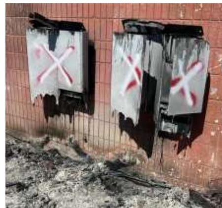
白色ペンキで赤色ペンキが覆い消されているダブルマーク：リチウム電池のパワーウォール、または太陽光発電設備がクリア、除去された印。
