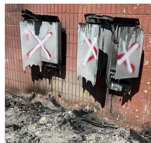
电池存储系统上的红色“X” = 需要 移除 红色上方有白色“X” “X” = 移除已完 成
