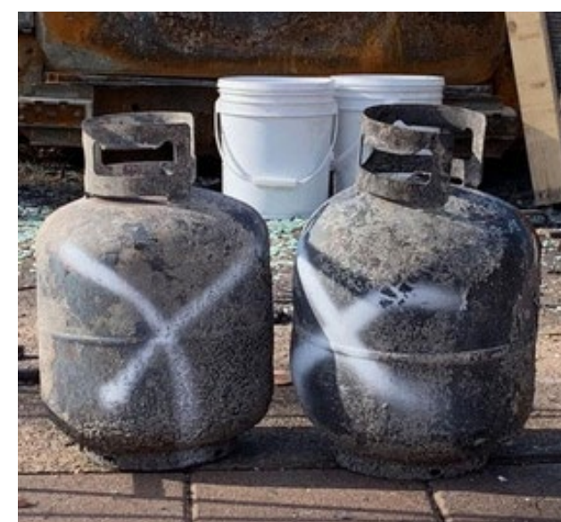
白色油漆或“X”标记 = 空的 HM 容器或将留在原处并在第 2 阶段移走的容器
