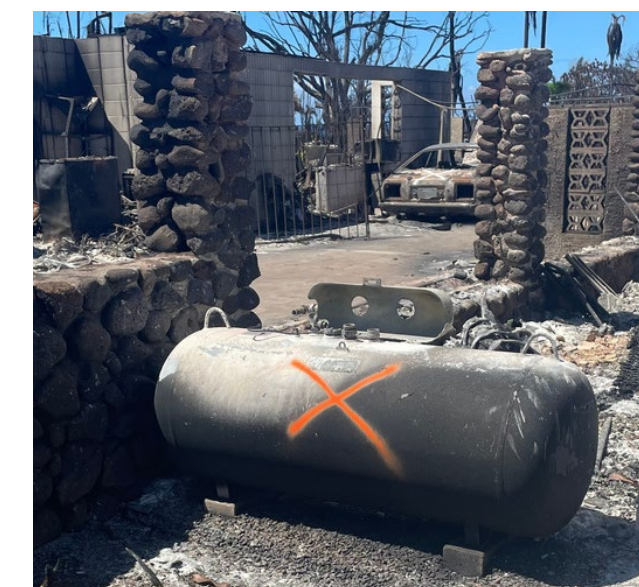
橙色油漆 = 化粪池系统位置、损 坏的变压器或现场遗留的高危物 品
