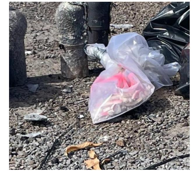
**Pintura rosa** = Material que potencialmente contiene asbesto
