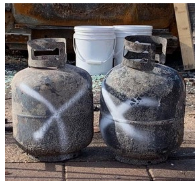
白色油漆或“X”標記 = 空的 HM 容器或將留在原處並在 第 2 階段移走的容器
