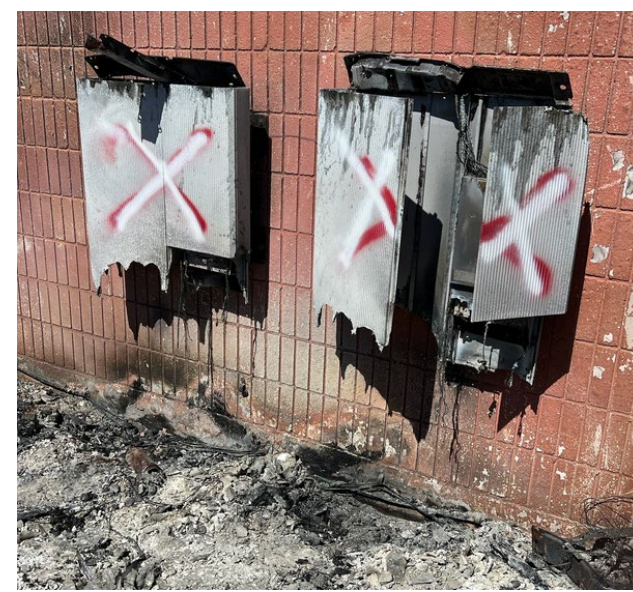
電池存儲系統上的紅色“X” = 需 要移除 紅色上方有白色“X” “X” = 移除 已完成
