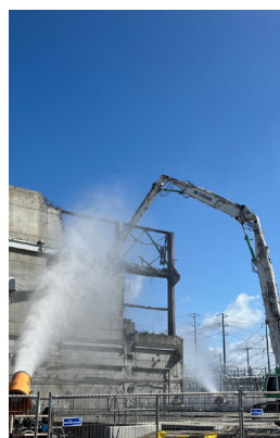
Sistemas de rociadores de agua crean una niebla fina para controlar el posible polvo generado por las actividades de limpieza
