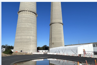
Recolección de agua en el área de montaje
