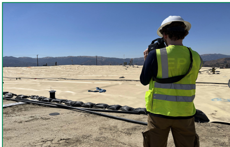
Un inspector de la EPA supervisa la instalación en curso de la cubierta de geomembrana en el CCL el 15 de septiembre de 25.
